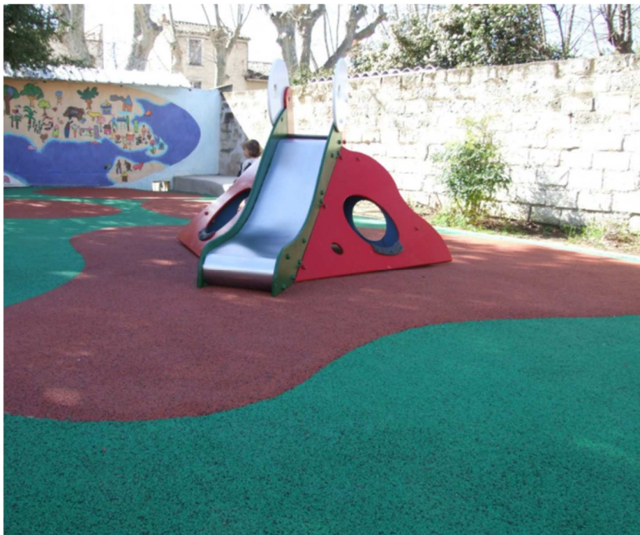
Rendu d'un sol souple EPDM sur les aires de jeux.
